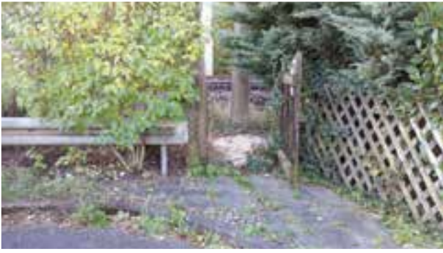
Foto (Dr. Otto Heimbucher): offener Zugang zu den Bahngleisen an der Sittenbacher Straße
