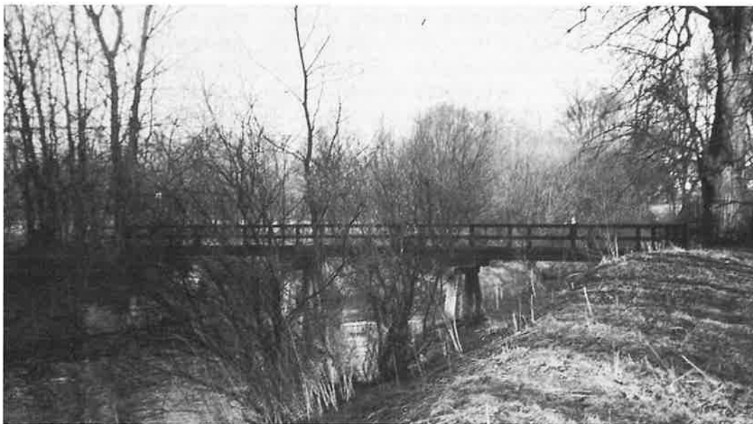
Pegnitzbrücke bei Oberbürg
