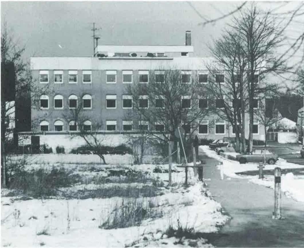
Volksschule in der Moritzbergstraße nach der völligen Umgestaltung 1975. An das alte Schulhaus von 1900 erinnern nur noch die Rundbogenfenster
