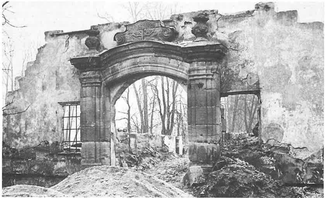
Während der Restaurierungsarbeiten am Schloßgebäude Oberbürg im Januar 1966
